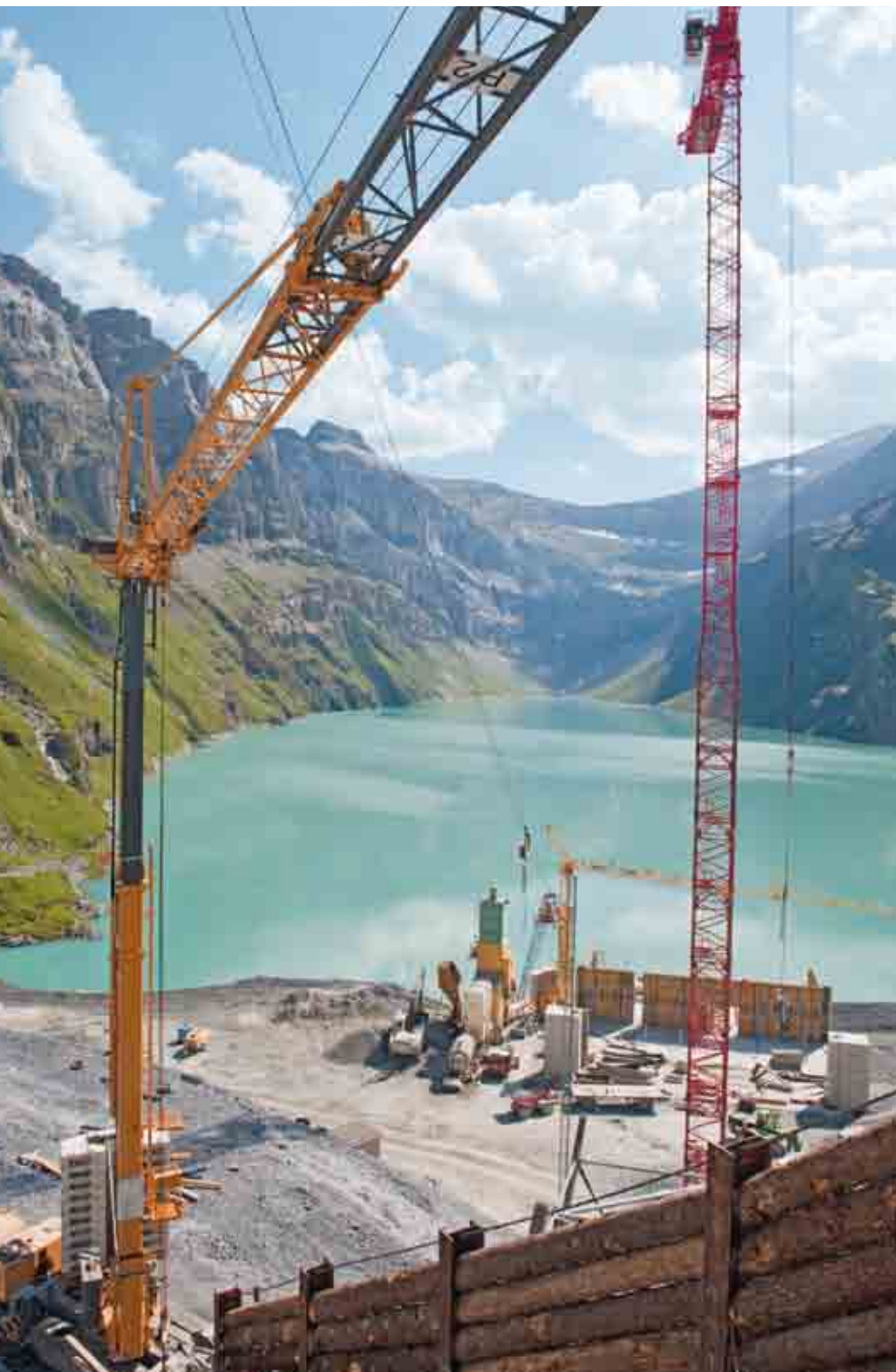
Der Limmersee und baumhohe Baukrane dominieren den Installationsplatz.
