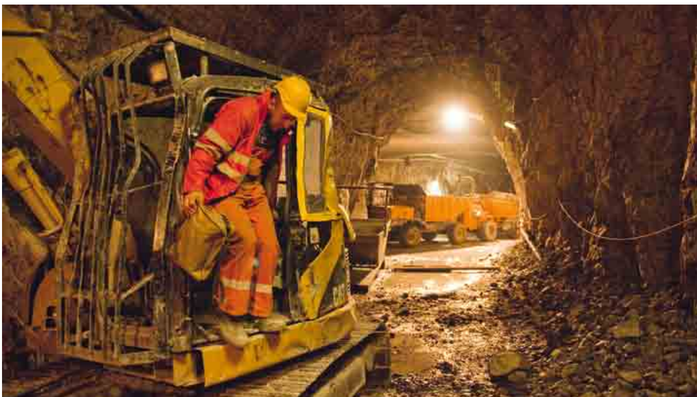
Der Vortrieb der Zugangsstollen erfolgt unter schwersten Arbeitsbedingungen.
