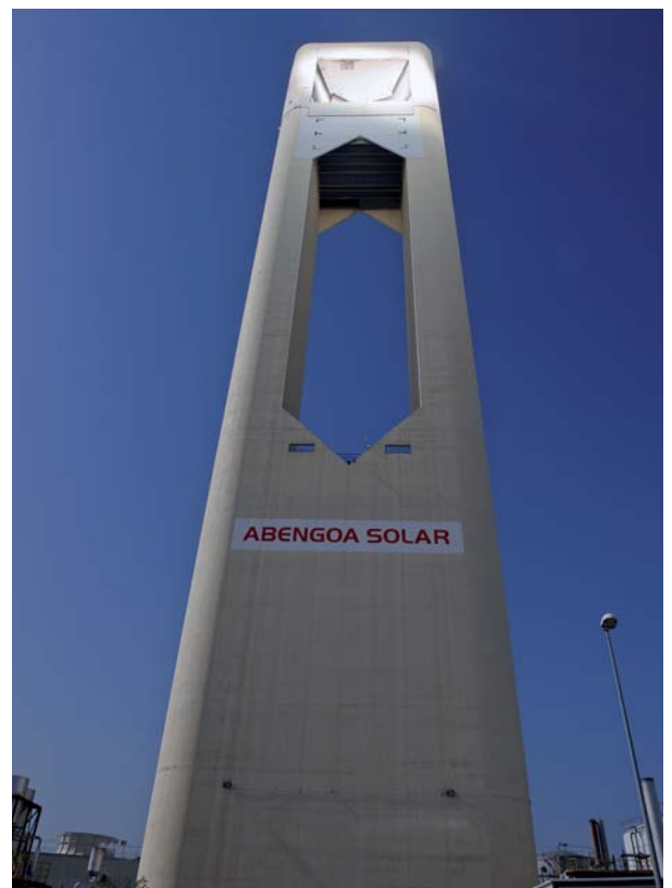
Einer der beiden Türme des Sonnenturmkraftwerks nahe Sevilla.
