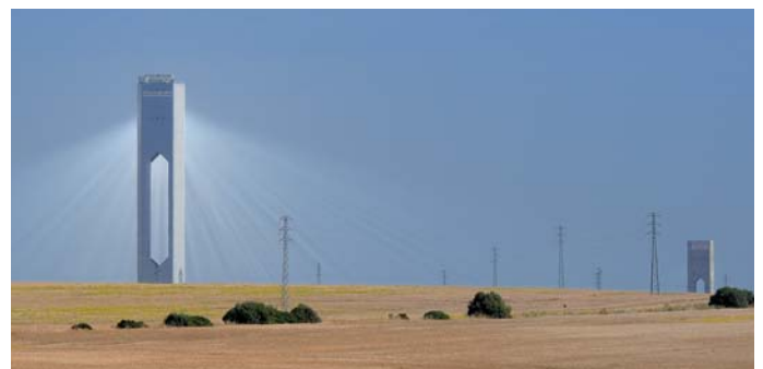
Die Hitze des konzentrierten Sonnenlichts produziert über eine Dampfturbine Strom.
