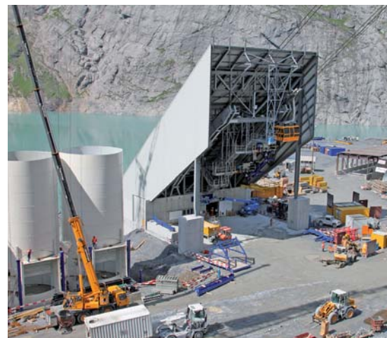
Talstation Bauseilbahn 2 im Ochsenstäfeli: Die mächtigen Kiessilos werden montiert.
