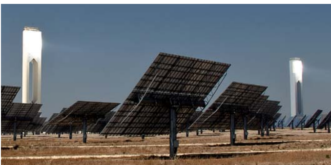
Die Sonnenstrahlen werden auf Wärmetauscher im Turm konzentriert.
