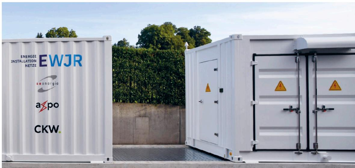
Axpo Batteriespeicher 2 MW/2,17 MWh, Realisierung 2019, Endkunde Elektrizitätswerk Jona-Rapperswil AG (EWJR), Schweiz
