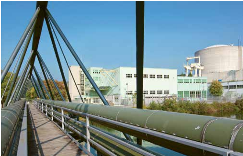
REFUNA-Rohrbrücke über dem Aarekanal
