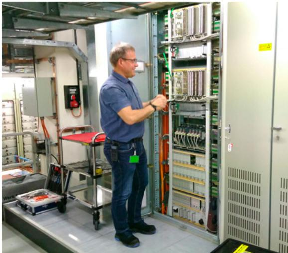
Servicearbeiten am Reaktorschutzsystem in der Fachgruppe Mess- und Regeltechnik.
