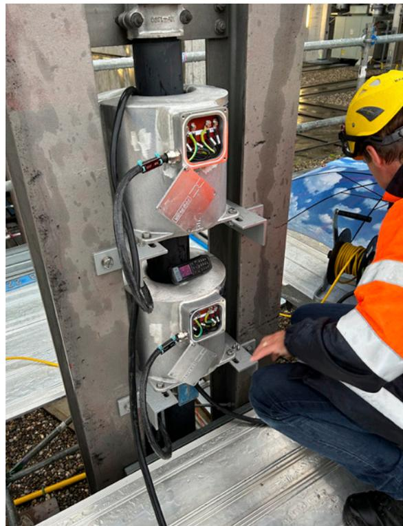
Inbetriebnahme von neuen Stromwandlern eines 220 kV Hochspannungskabels.
