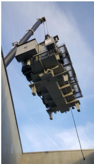
Die 42 bis 71 Tonnen schweren Trafos werden mit Kran über die Dachöffnung in das Unterwerk gehievt.
