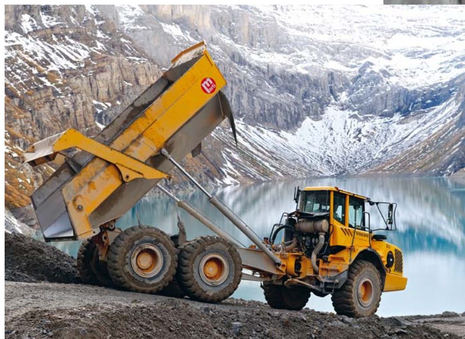
Ein seltenes Bild in den Bergen: schweres Gerät für den Bau des Grossprojekts.
