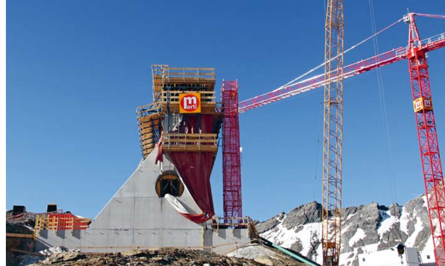
Der Muttsee wird mit einer Gewichtsstaumauer gestaut – 1 km lang und bis zu 35 Meter hoch.
