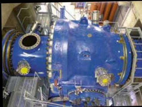
**Fertig:** Der Kugelschieber ist an seinem Einsatzplatz, eingebaut zwischen der Druckleitung und der Einlaufspirale.
