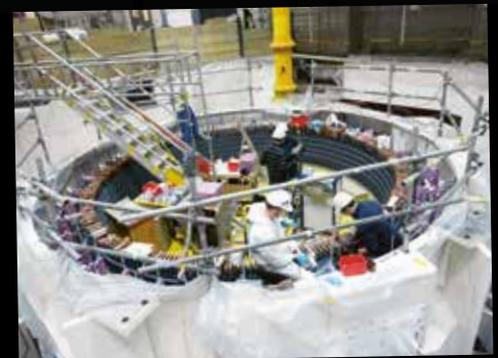
**Arbeiter im Einsatz:** Das Abstimmen von Rotor und Stator ist zeitaufwändige Millimeterarbeit.
