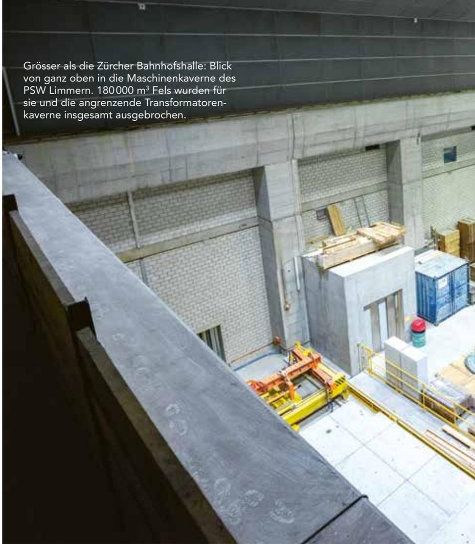
Grösser als die Zürcher Bahnhofshalle: Blick von ganz oben in die Maschinenkaverne des PSW Limmern. 180000 m<sup>3</sup> Fels wurden für sie und die angrenzende Transformatorenkaverne insgesamt ausgebrochen.
