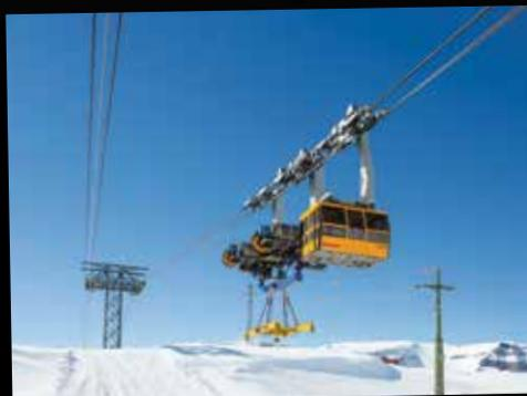
**Bauseilbahn 2:** Sie transportiert Lasten bis zu 25 Tonnen zum Muttsee hoch und wird ab September 2016 zurückgebaut.
