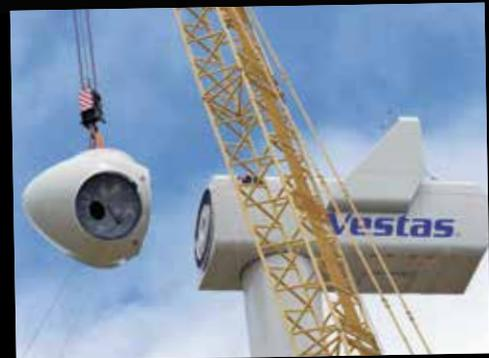
**Nabe:** Millimeterarbeit ist gefragt, wenn die 32 Tonnen schwere Nabe auf den Rumpf aufgesetzt wird.
