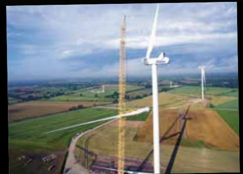
**150 Meter hoch:** Nach rund zwei Tagen sind die neun Einzelteile zu einem Windrad zusammengefügt.
