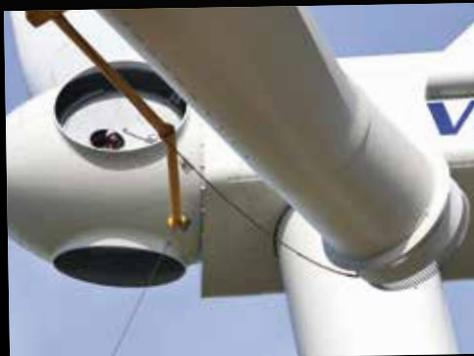
**Heikle Phase:** Ein Arbeiter in der Nabe überwacht die heikelste Phase, wenn die Rotorblätter montiert werden.
