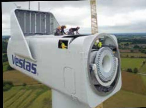
**Nacelle:** In luftiger Höhe montieren Arbeiter im Rumpf, der sogenannten «Nacelle», die 57 Tonnen schwere Antriebseinheit.
