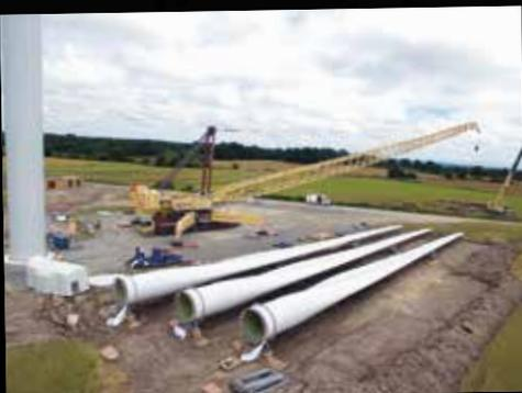
**Bereit zur Montage:** Die Turmelemente stehen. Jetzt werden mit einem riesigen Kran Rumpf und Rotorblätter angehoben.
