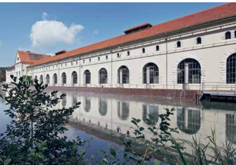
Das Hydraulische Kraftwerk Beznau.
