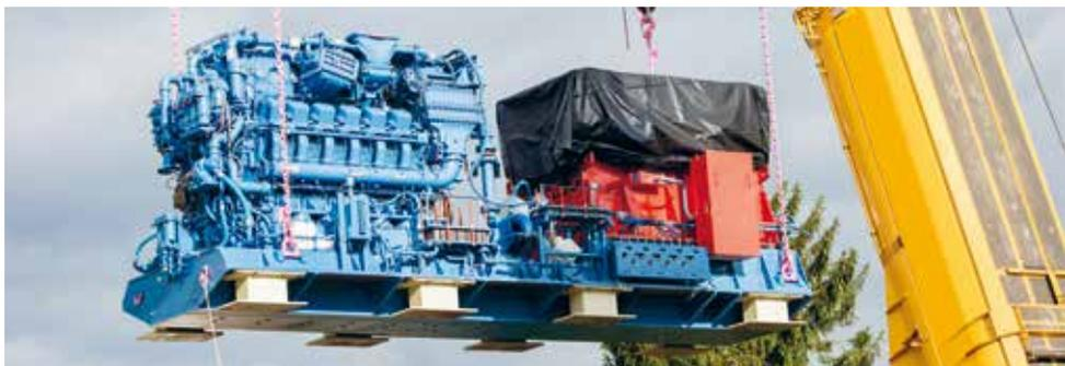
Einer von vier neuen Dieselgeneratoren für eine autarke Notstromversorgung.
