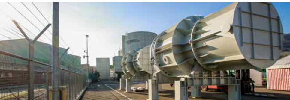
Sicherheit durch Prävention: Die neuen Reaktordruckbehälterdeckel werden angeliefert.
